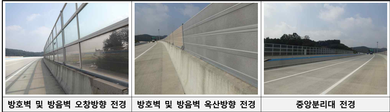
[방호벽 및 방음벽 전경]
