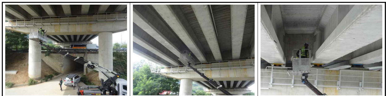
[고소작업차를 이용한 근접조사 실시]
